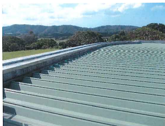
写真 51 覆屋施設の屋根部
