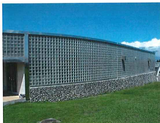
写真 52 覆屋施設の壁面ガラスブロック
