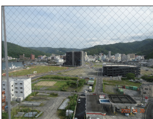
▲工事中のマリンタウン
