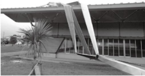
暴風により屋根が破損した屋内ゲートボール場
