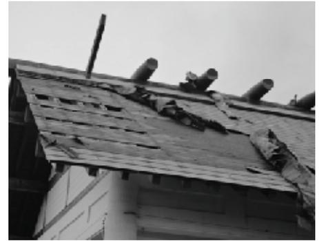
暴風により破損した相撲場の屋根
