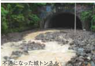
不通になった城トンネル
