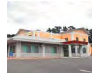
⑦ 有良汚泥再生処理センター
