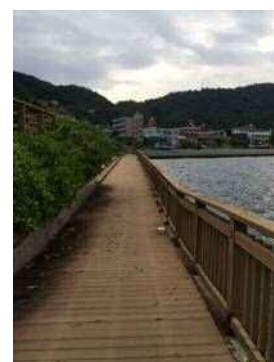
＜名瀬港地区の遊歩道＞
