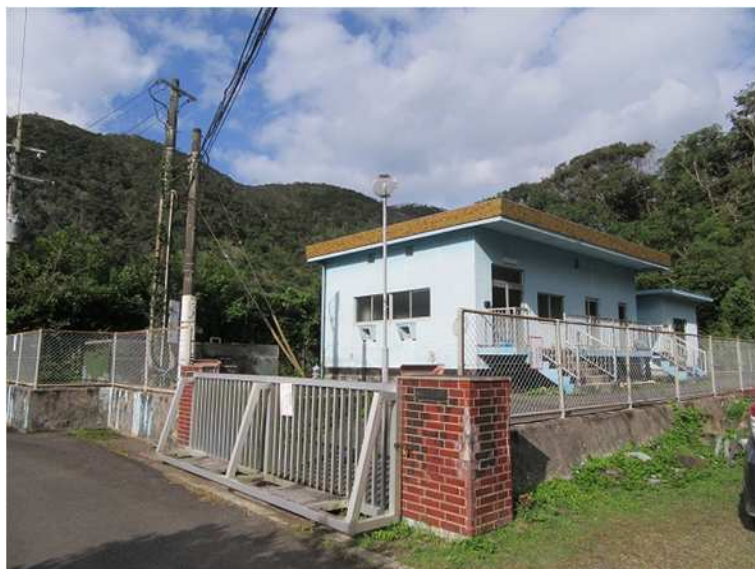
<写真－小宿浄水場>
