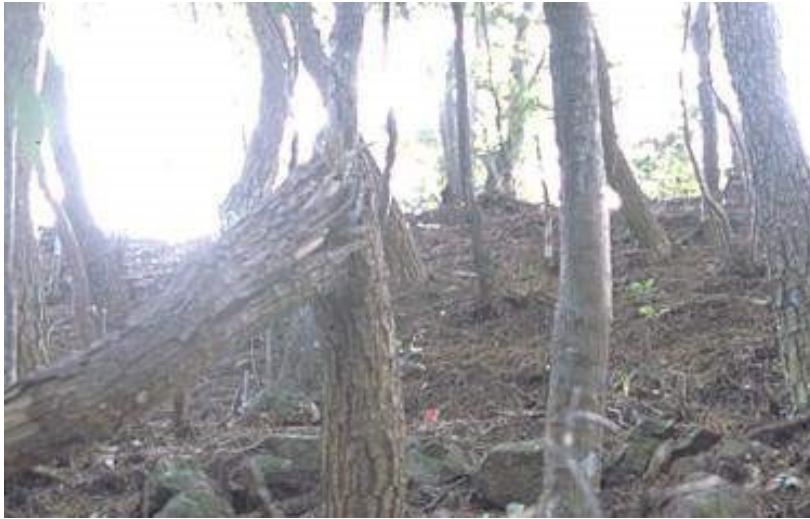
第 27 図 北側曲輪群切岸 (A 地区)
