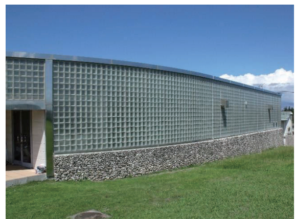
写真 52 覆屋施設の壁面ガラスブロック
