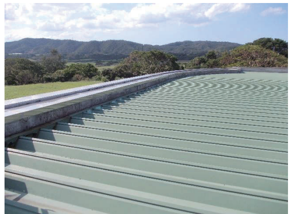
写真 51 覆屋施設の屋根部
