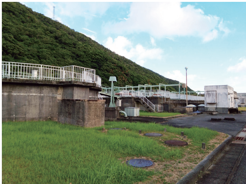
浄化センター（名瀬終末処理場）
