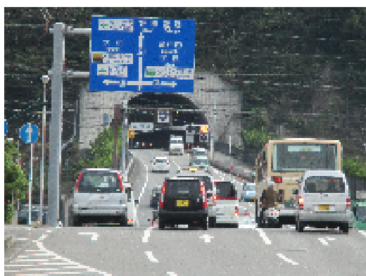
写真一和光トンネル
