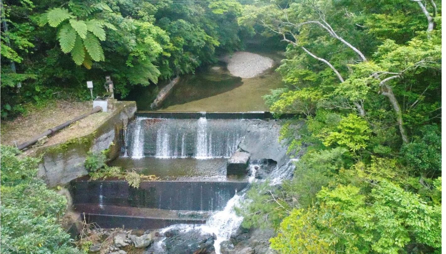
轟水源（平田浄水場水源）
