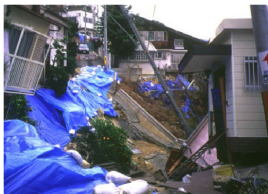
滑動崩落による被害状況（兵庫県南部地震） (国土交通省「わが家の宅地安全マニュアル」より)
