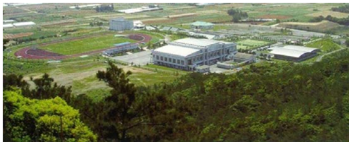
②スポーツ・レクリエーションの拠点施設である太陽ヶ丘運動公園
