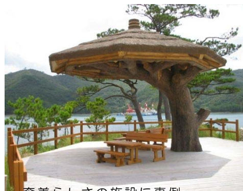
奄美らしさの施設に事例 琉球松と萱葺き屋根の造形シェルター
