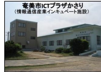
ICTプラザかさり
