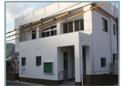
山間交流施設
