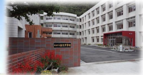
金久中学校校舎建築
