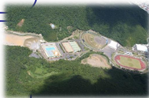
名瀬運動公園施設改修
