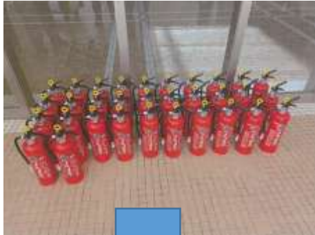
消火器 32本を更新
