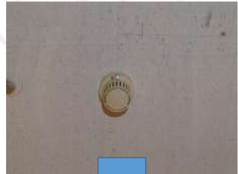
火災報知器 6個を交換
