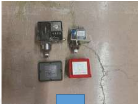
スプリンクラー設備 圧力スイッチを交換
