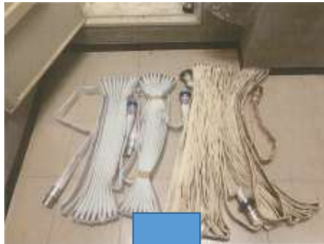
消火栓ホース 30本を更新
