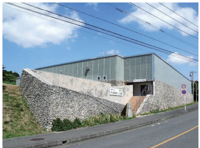
写真 47 宇宿貝塚史跡公園史跡保護覆屋施設
