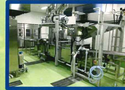
揚物・焼物・蒸物調理室
