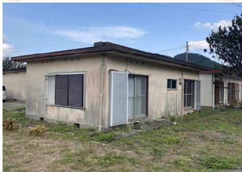
建物外観 (鉄筋コンクリート造平屋)
