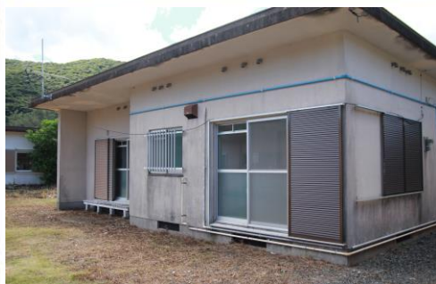
建物外観 (鉄筋コンクリート造平屋)
