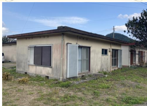
建物外観 (鉄筋コンクリート造平屋)
