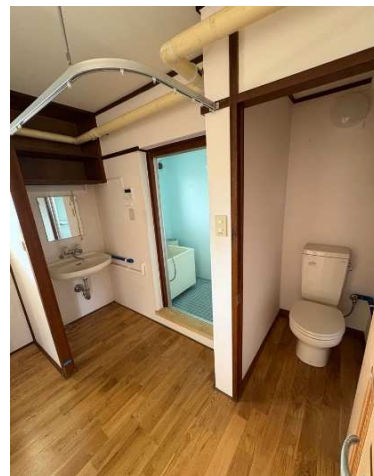
トイレ・洗面台・風呂
