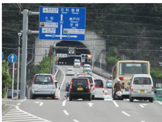
写真一和光トンネル
