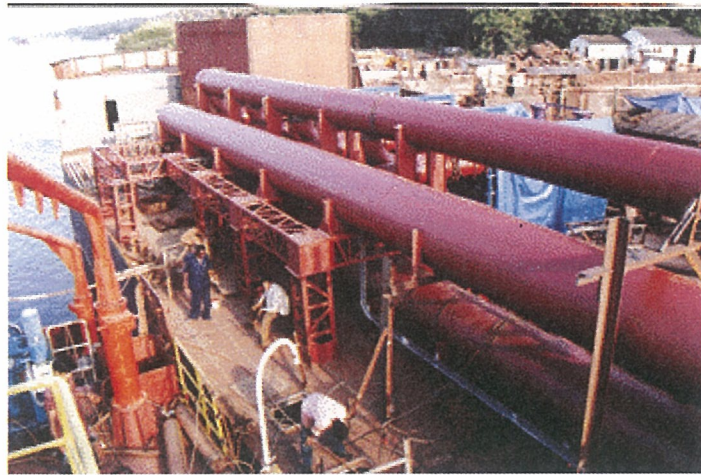
図 5-12 インド洋上実証プラントの取水管
