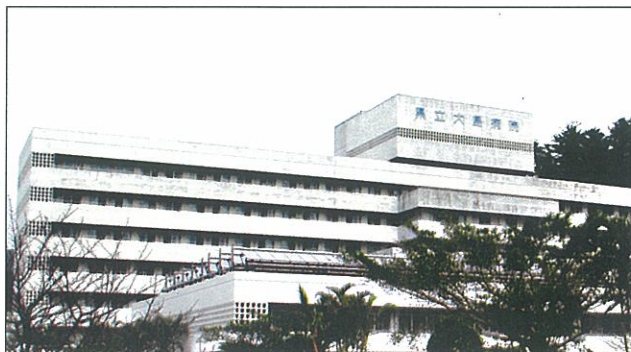
※ 県立大島病院に導入されている太陽熱集熱器の例
