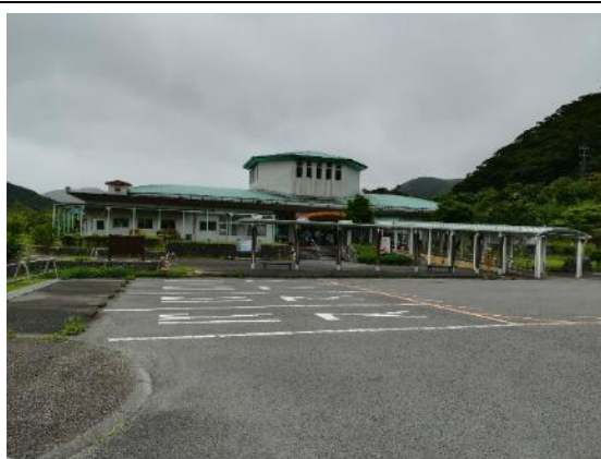
施設正面（駐車場側）から
